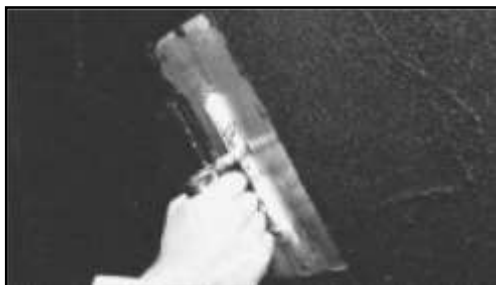
Рис"но13 - Нанесениетретье#ослоя#идроизоляции.
