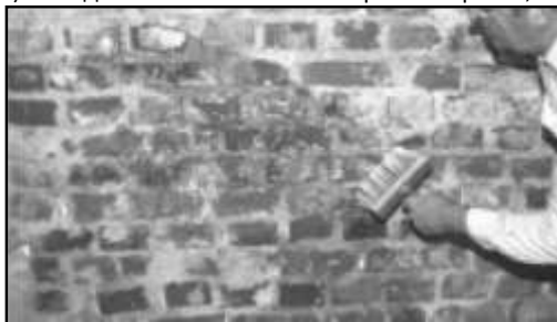
Рис. 10 - Нанесение грунтовки (с помощью исты).
