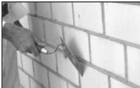
Рис"но9 - Под#отов(а(ирпичнойповерхности,очист(а выступающе#оизшвовраствора.
