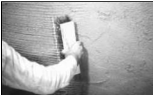
Рис. 12 - Нанесение первого слоя гидроизоляции.
