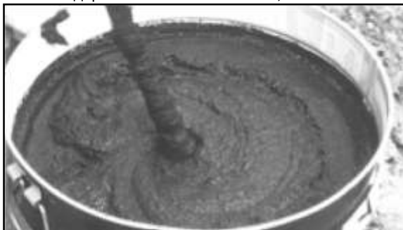
Рис" но11 - При#отвлениерастворнойсмеси
